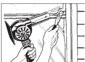
Pour enlever le mastic soutenant une vitre brisée, commencez par retirer soigneusement la vitre. Pour enlever le mastic de soutien d'une vitre intacte, veillez à ne pas diriger le flux d'air chaud vers le verre afin d'éviter qu'il ne se fêle sous l'effet du choc thermique. Le verre peut être facilement protégé à l'aide d'un large couteau à mastic. Agitez le pistolet en direction du mastic jusqu'à ce que celui-ci se ramollisse. Enlevez ensuite le mastic à l'aide d'un couteau à mastic.
